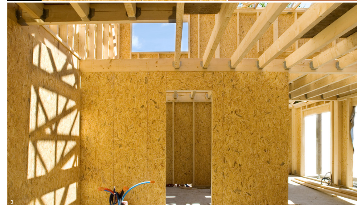
1, 2 et 3. Panneaux de contreventement pour murs à ossature bois
